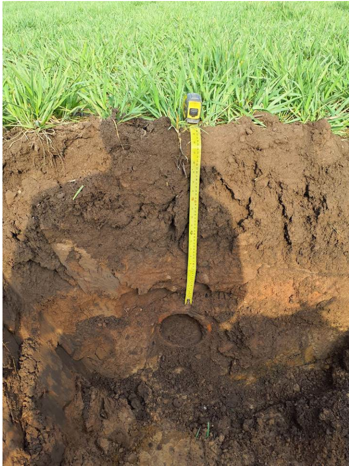
TT01 Culvert Level
